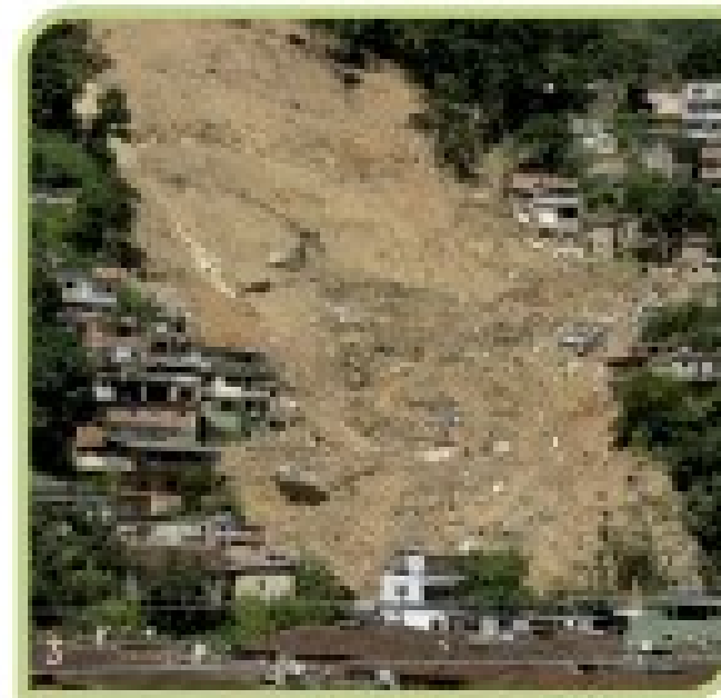
Ocupações em áreas de risco, como encostas e margens de rios.
