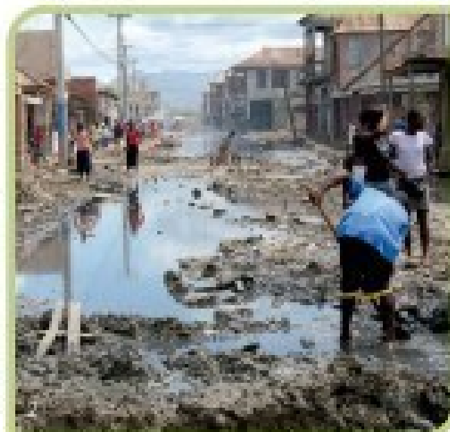
Falta de infraestrutura básica (saneamento, drenagem, transporte).
